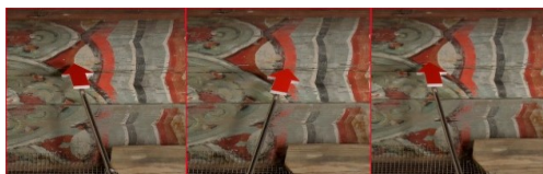
図 2 観月堂南面内部壁梁終端部
